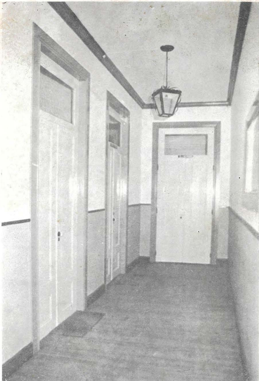
Fig. 50 — Entrada pela Rua de S. João e corredores de serviço.
