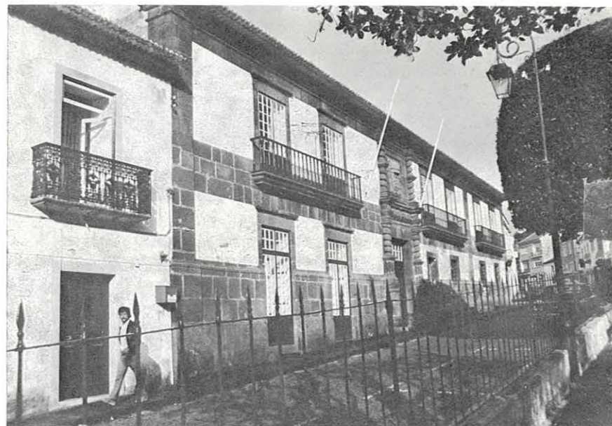
Fig. 1 — Fachada principal do Paço Municipal das Velas em 1984.
