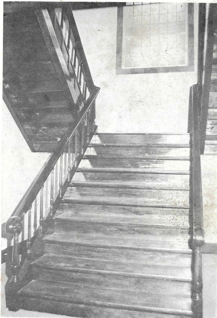
Fig. 34 — Escada da entrada principal.
