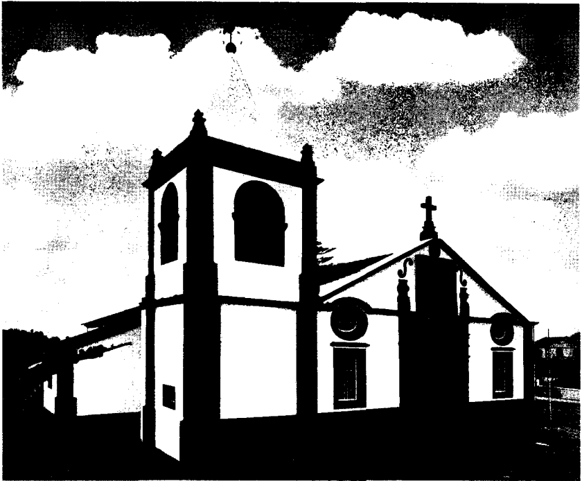
Actual Igreja Matriz de N. S. do Rosário de Vila Nova do Topo, após o terramoto de 1757.
