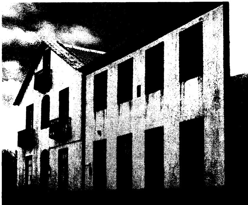
Antigas casas da Câmara e Cadeia do concelho do Topo, hoje transformadas em habitações.
